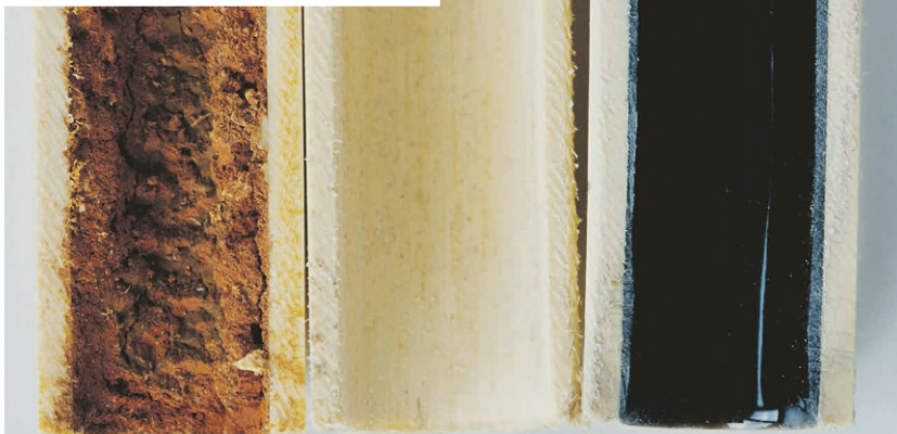
Bodenheizungsrohr: Vor, während und nach der Sanierung mit dem HAT-System.
