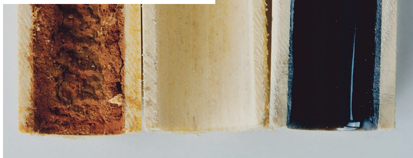
Conduite de chauffage au sol: avant, pendant et après l'assainissement avec le HAT-System.
