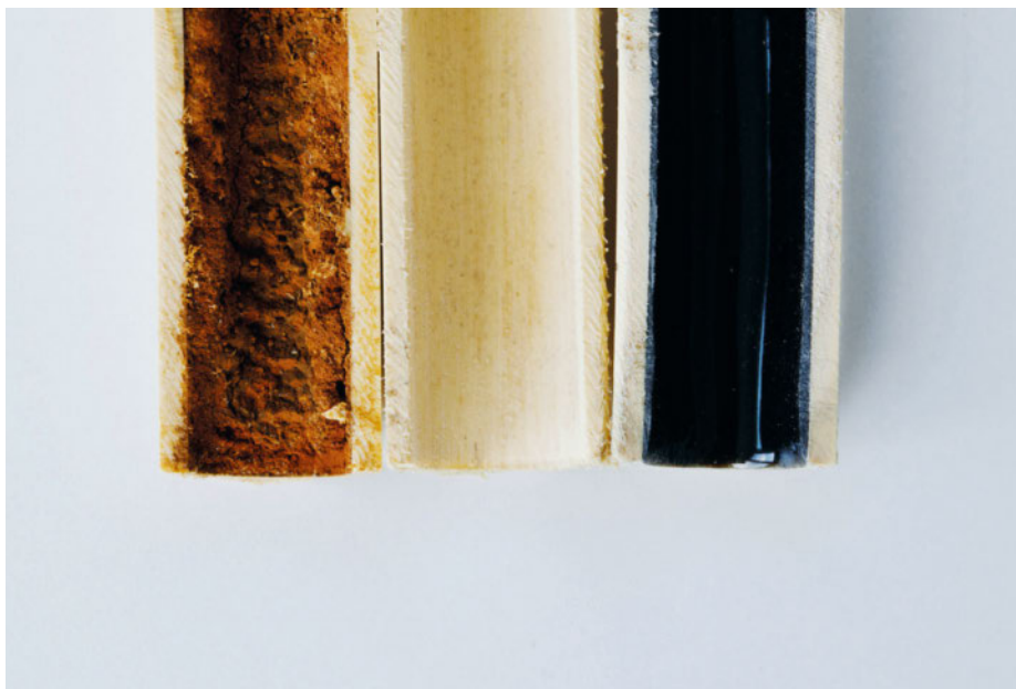
Conduite de chauffage au sol: avant, pendant et après l'assainissement avec le HAT-System.
