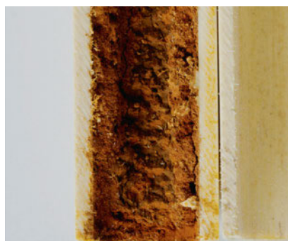
Conduite de chauffage au sol: avant, pendant et après l'assainissement avec le HAT-System.
