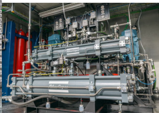
Der Wasserstoff wird von 30 auf 500 Bar komprimiert.
