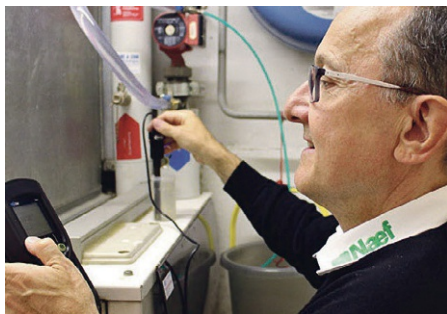
Aufschlussreich: umfassende Prüfung der Bodenheizung durch die Naef Group.
