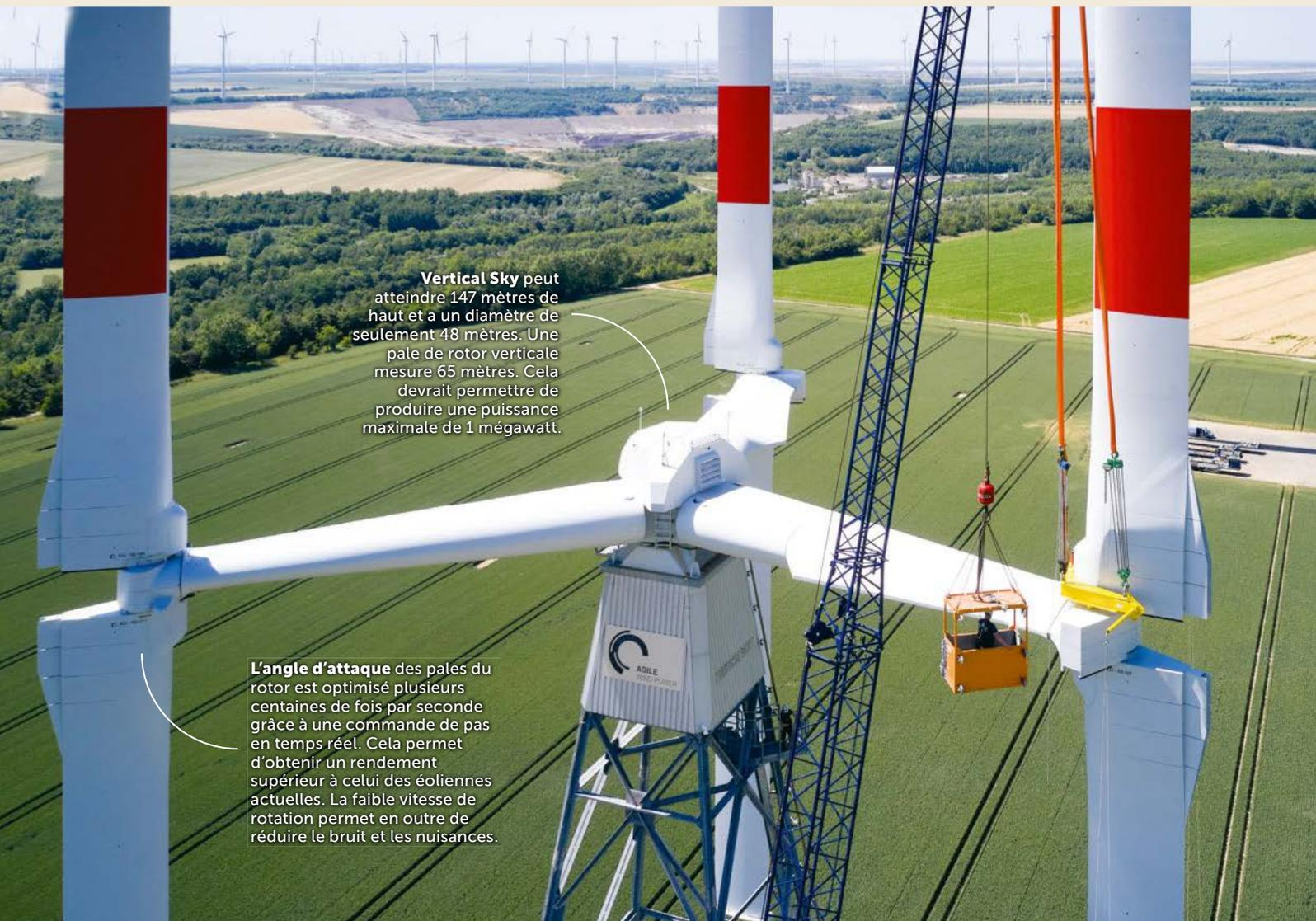
**Vertical Sky** peut atteindre 147 mètres de haut et a un diamètre de seulement 48 mètres. Une pale de rotor verticale mesure 65 mètres. Cela devrait permettre de produire une puissance maximale de 1 mégawatt.
