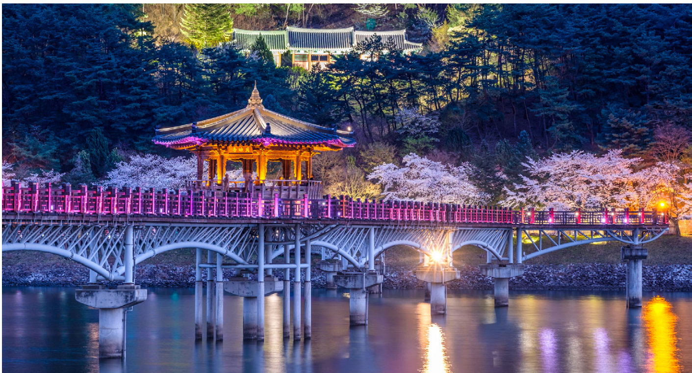
Mondlichtbrücke Die Holzbrücke bei Andong ist ein beliebtes Ausflugsziel.
